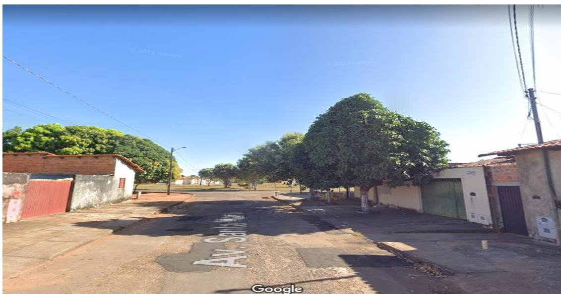
Santa Maria interligando a rotatória já pavimentada
